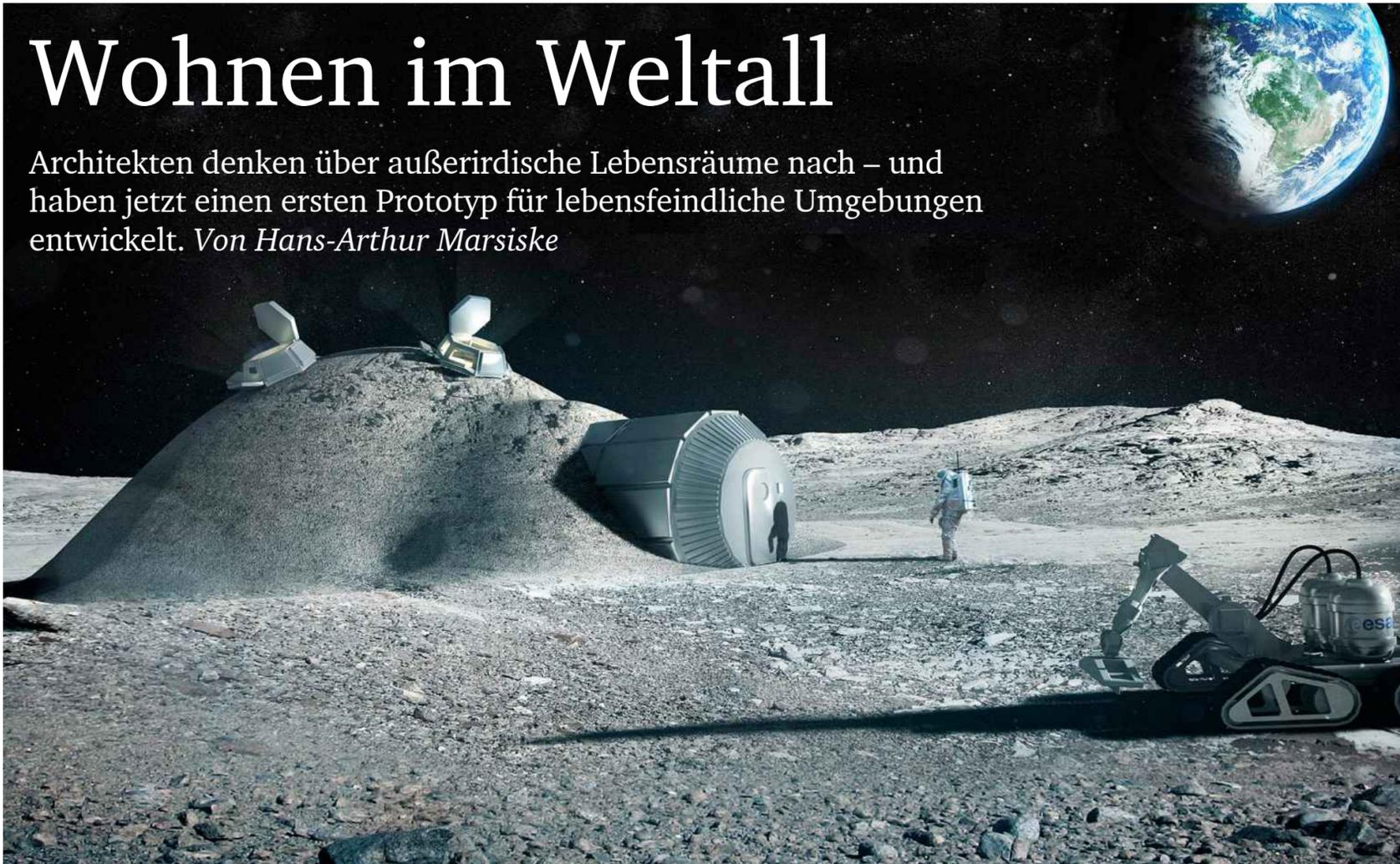
Mit Mondstaub und einer passenden Salzlösung will die Europäische Raumfahrtagentur ESA eine Station auf dem Erdtrabanten mit überdimensionalen 3D-Druckern errichten. Die künstliche Gesteinsschicht schützt vor der kosmischen Strahlung. Getestet wurde das Verfahren schon – auf der Erde.
